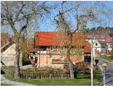
Abb. 3: Hofteich und Wohnhaus der Familie Mario Pöschmann (ehemals „Teichbräunel's“ in Trockenborn)
