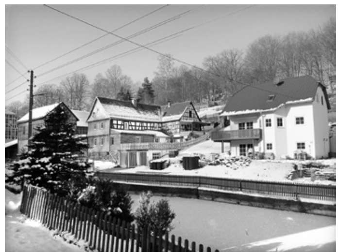
Alte und neue Häuser sind in Rattelsdorf zu finden
